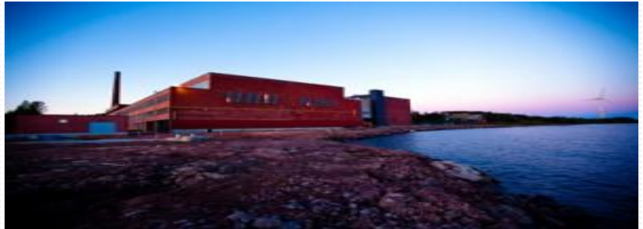
Data center, Google localizada em Hamina, na Finlândia ,
